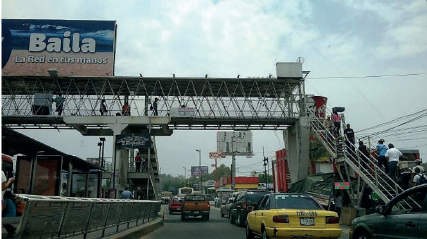
Figura 4. Puente peatonal en la salida a la Carretera a Chapala, en Tlaquepaque. Foto propia, 2014.
