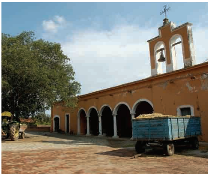
📷 78 Fachada de arquería rematada por espadaña
