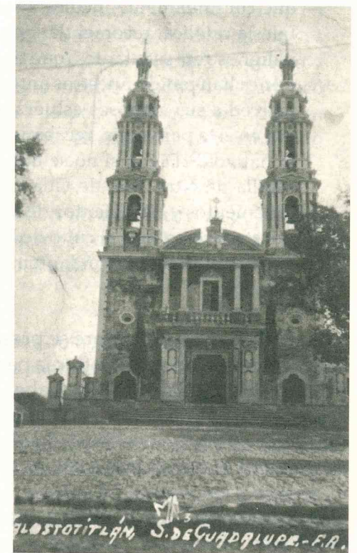
Santuario de Guadalupe, reedificado en 1857 sobre la estructura de una pequeña capilla.
