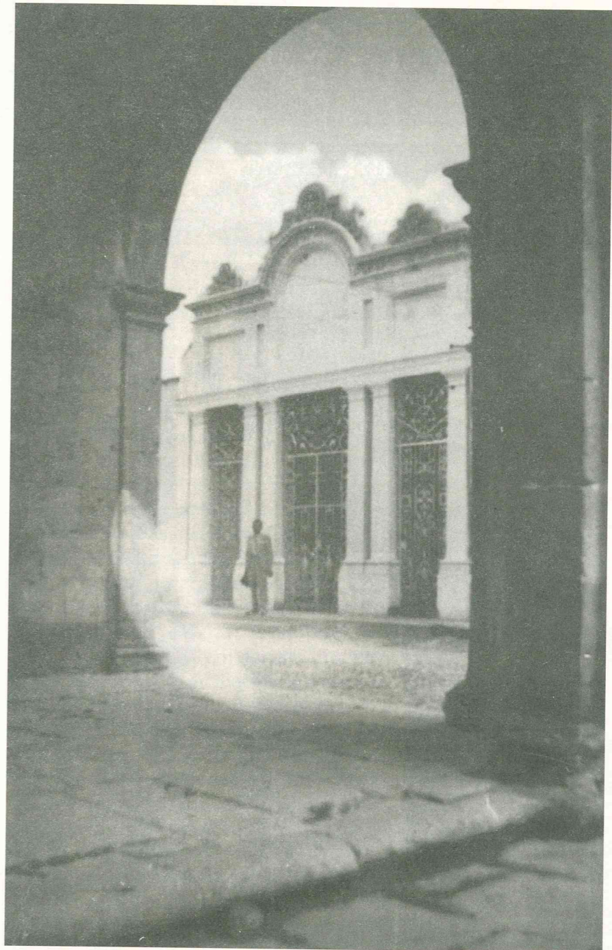
Auditorio Hidalgo, después "salón del PRI" y ahora sede de juzgados. Edificio que conserva una bella fachada ecléctica, y que a pesar de su valor histórico-artístico el Ayuntamiento Municipal lo tiene en un estado vergonzoso en su interior.
